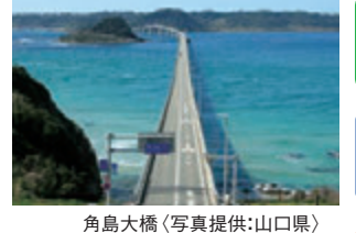
角島大橋(写真提供:山口県)
