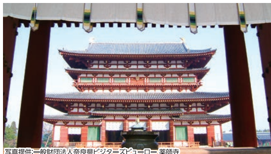
写真提供:一般財団法人奈良県ビジネスマネジメント 薬師寺
