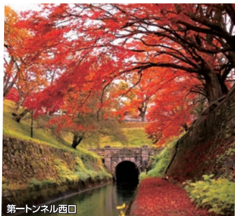
第一トンネル西口
